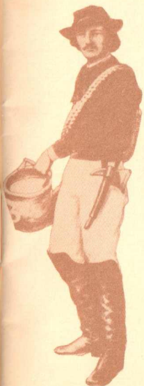
Tercera de Bombas.
